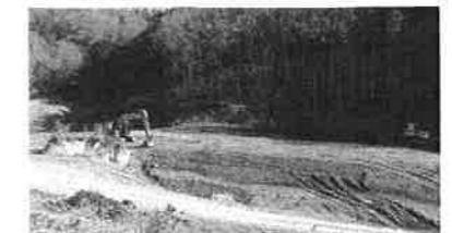
大井町山田字石河ら山土地改良区で盛り土工が進む農地土地改良事業(地権者数17人)。計画総土量約22万㎡のうち、県工事で発生した残土10~12万㎡や、さがみ縦貫道路建設で発生した残土約8万㎡などを活用する。開発面積は約3.2ha。
