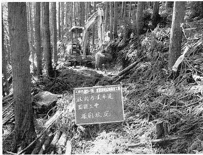
森林内の路網整備 (美川建設)
