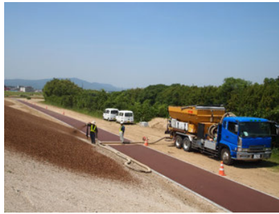
破碎チップで法面保護・緑化
