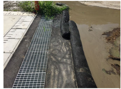
フィルターソックスで土砂流出防止
