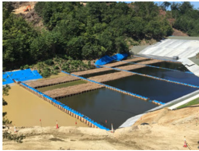
竹ソダ濁水処理工法
